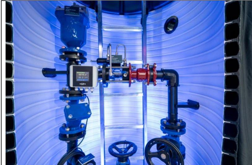
Soluzione su misura per camere di misurazione isolate idraulicamente nelle aree urbane che aiuta le aziende di servizi pubblici a monitorare il consumo idrico, individuare le perdite e migliorare l'efficienza. La camera Flowise protegge i dispositivi di misurazione o le valvole, come le valvole di sfiato VAG o le valvole di regolazione della pressione NeoFlow, da eventuali danni.
