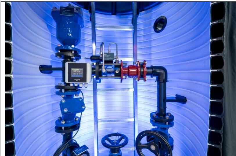
Solution sur mesure pour les chambres de mesure isolées hydrauliquement dans les zones urbaines qui aide les services publics à surveiller la consommation d'eau, à détecter les fuites et à améliorer l'efficacité. La chambre Flowise protège les dispositifs de mesure ou les vannes, telles que les vannes de purge VAG ou les vannes de régulation de pression NeoFlow, contre tout dommage.
