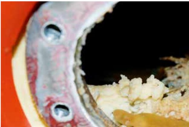
40 Zentimeter hohe Kalkablagerungen auf dem Speicherboden im Warmwasserspeicher
