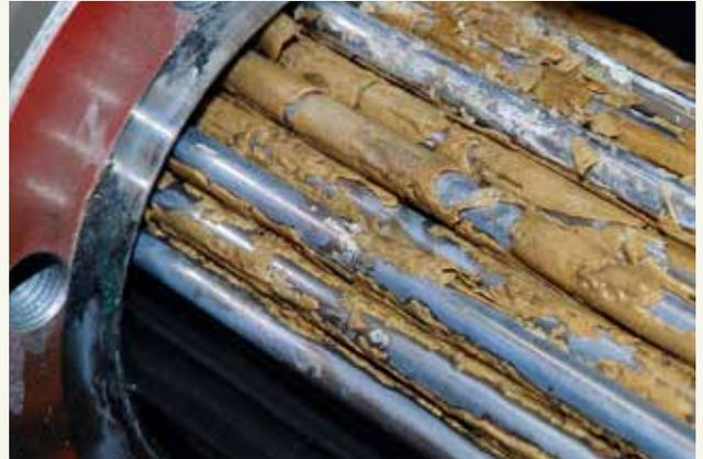
Rohrbündelübertrager mit Kalkablagerungen
