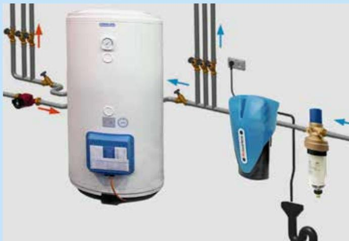
Schematische Darstellung einer Trinkwasserinstallation mit JRG Coral force 3000
