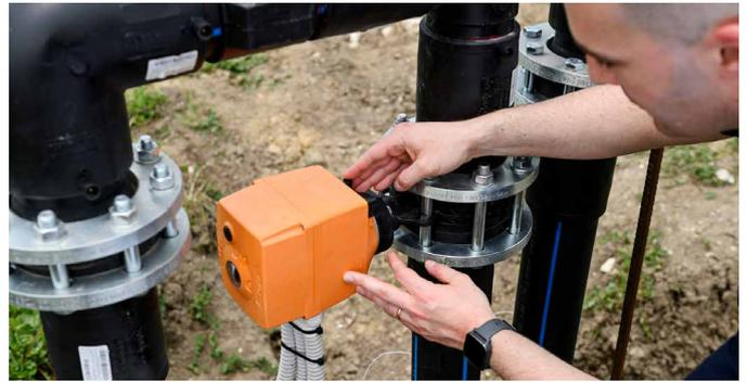
Grças às válvulas acionadas eletricamente, o sistema de irrigação tem um tempo de resposta melhor e pode ser controlado de forma centralizada.
