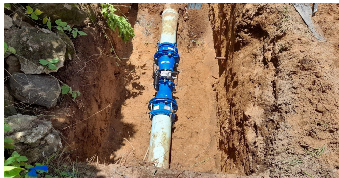
Para controle avançado de pressão, a NeoFlow foi instalada em duas zonas de fornecimento de pressão.
