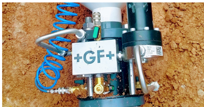
A NeoFlow precisa de 40% menos tempo para instalação do que uma VRP de metal.
