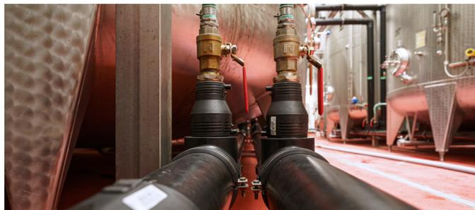
A construção 3 em 1 de plástico soldável – consistindo em tubo, isolamento e revestimento robusto – tempo de instalação reduzido ao mínimo.
