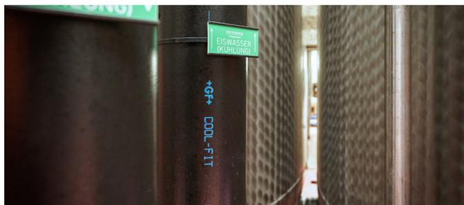
O revestimento externo de PEAD altamente resistente protege a espuma de isolamento e fornece uma camada adicional de isolamento.
