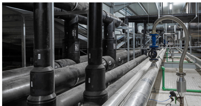
Quase 2.000 metros de tubulação COOL-FIT foram instaladas na Champinter.
