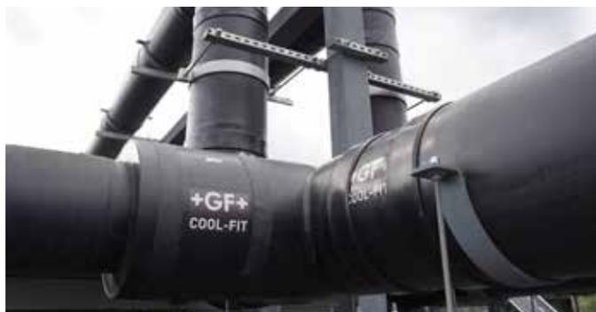
O sistema de tubulação leve e em grande parte pré-fabricado foi facilmente montado e unido de forma confiável por eletrofusão em poucos minutos.
