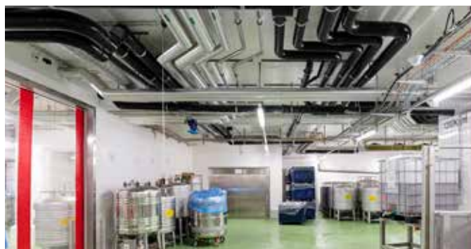
A modernização envolveu um trecho de cerca de 150 metros do sistema.
