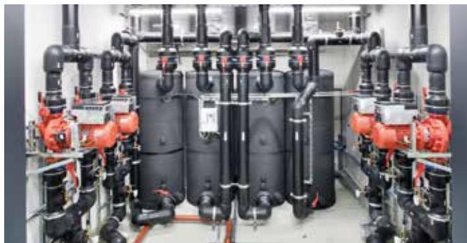
COOL-FIT PE Plus no sistema de refrigeração BADEN CLOUD® nas instalações de Appenweier.
