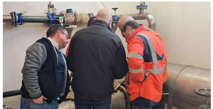
Com o suporte técnico da GF Piping Systems, a antiga VRP de ferro fundido foi substituída com sucesso pela NeoFlow.
