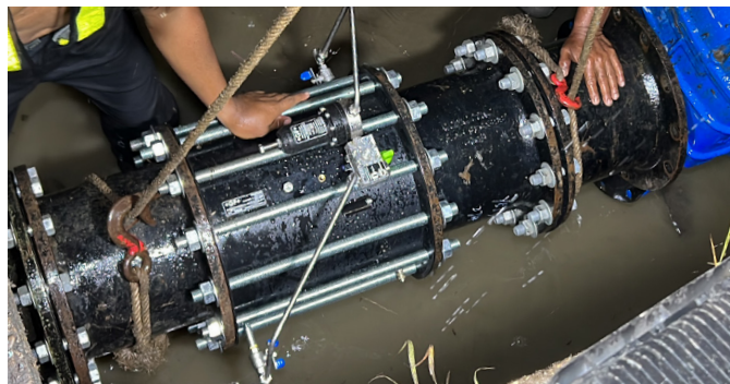
A instalação ocorreu sem complicações.
