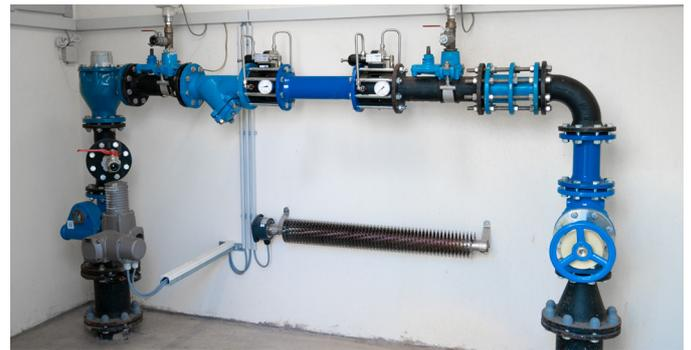
Devido à sua construção simples, sem haste do atuador e diafragma, o NeoFlow tem uma longa vida útil e requer pouca manutenção.
