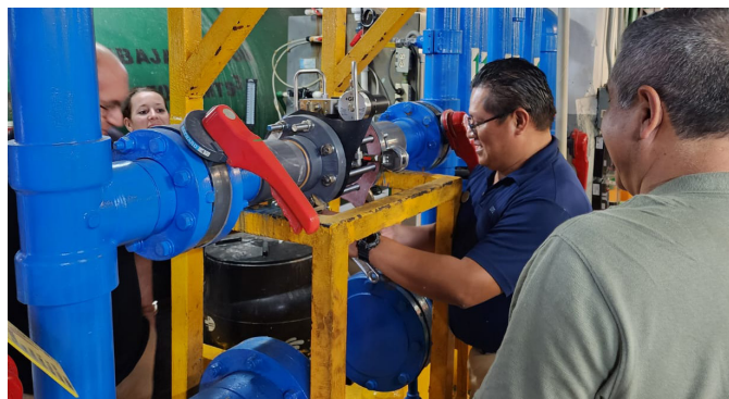
Graças ao design compacto de seu corpo, a válvula é até nove vezes mais leve e pode reduzir o tempo de instalação em até 40% em comparação com uma VPR de metal padrão.
