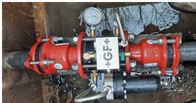
Graças à sua construção de fluxo axial, o NeoFlow garante um fluxo estável de 1% a 100% de abertura, mesmo com um pequeno diferencial operacional.
