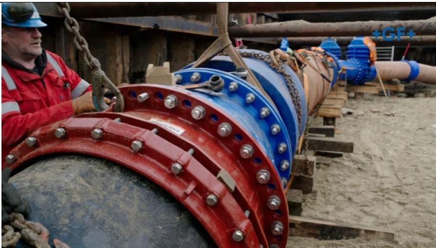
A MULTI/JOINT® 3000 Plus na dimensão DN1000 já foi instalada com sucesso na Holanda.
