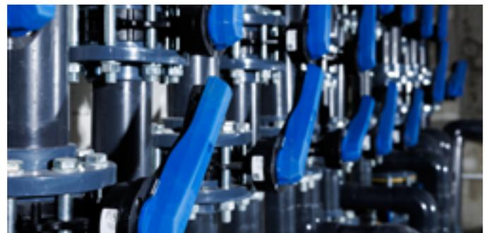
Dank identischer Einbaulängen und 60 Prozent weniger Gewicht als Metall kann die Absperrklappe 565 in wenigen Minuten installiert werden.
