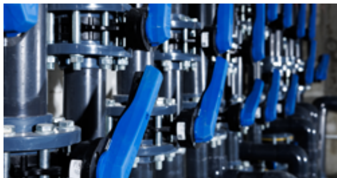
Grâce à des longueurs d'installation identiques et à son poids inférieur de 60 % comparé au métal, la vanne papillon 565 peut être installée en quelques minutes.
