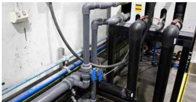
Foram instalados tubos, conexões e válvulas esfera COOL-FIT PE Plus em d63. Adaptadores de união PE/SS foram usados para permitir flexibilidade na movimentação das máquinas.
