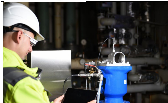
Installation eines VAG DUOJET @ON Smarten Be- und Entlüftungsventil in einem Schacht
