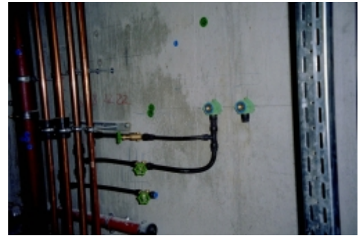
Der Bad-Komfort der 69 Doppelzimmer im Anbau durfte unter anderem nicht unter Fließgeräuschen leiden. Die Kunststoff ummantelten MT-Verbundrohre kommen dieser Forderung entgegen.
