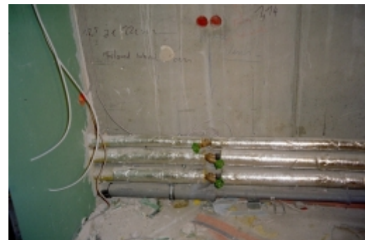
Der Bad-Komfort der 69 Doppelzimmer im Anbau durfte unter anderem nicht unter Fließgeräuschen leiden. Die Kunststoff ummantelten MT-Verbundrohre kommen dieser Forderung entgegen.
