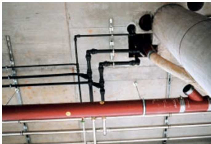
6800 Meter MT-Verbundrohr sowohl als Strangsteigebränge als auch als Verteilleitung.
