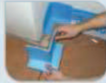
2 Install angle & door profiles
