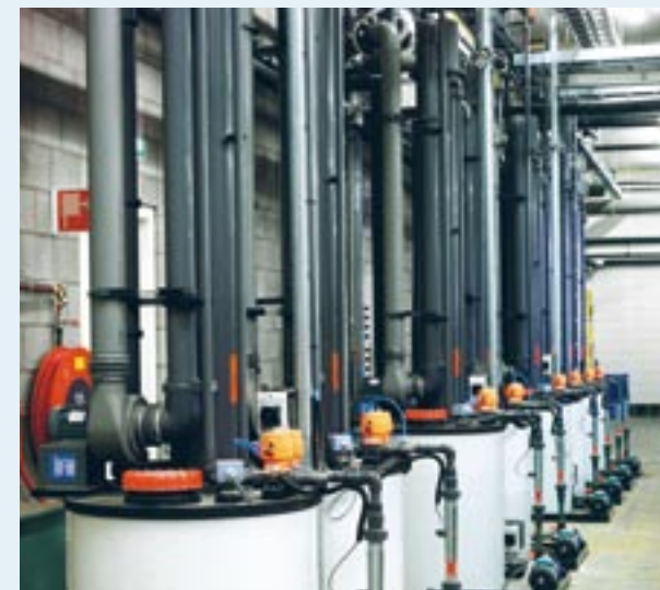
Verteilleitungen für Chemikalien mit PVC-U.
