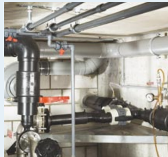
Abwasserleitungen für Chemikalien in CONTAIN-IT Plus oder FUSEAL® (PVDF/PP).
