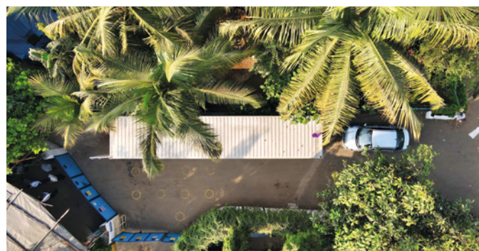
Mobile Wasseraufbereitung in Containern dank Prozessautomatisierungslösungen.
