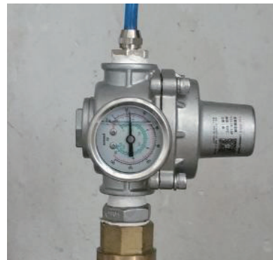
图 2-5 稳压阀安装图
