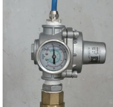
图 2-5 稳压阀安装图
