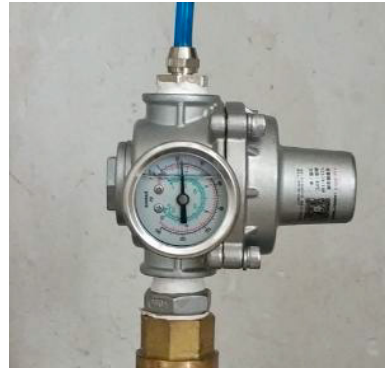
图 2-5 稳压阀安装图
